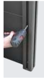
Vissage du poteau
