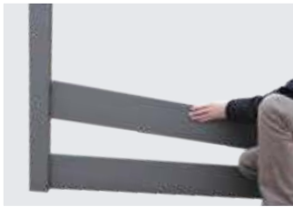
Pose des lames
